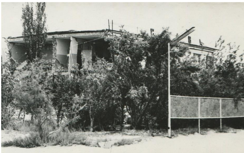
Рис.5. Состояние здания ГНПУ после землетрясения 17.05.1976.
